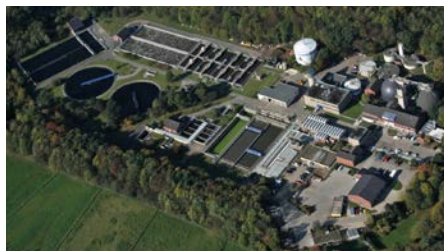
Kommunale Kläranlagen setzen ebenso auf die MSE-Technologie wie Industriekunden.
